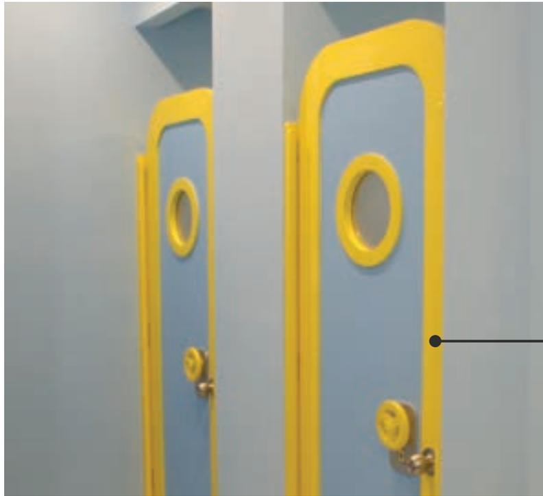
PUERTAS TIPO SUBMARINO EN MDF HIDRÓFUGO LACADO CON MARCO DE MADERA SÓLIDA Y VENTANILLA EN ACRÍLICO
