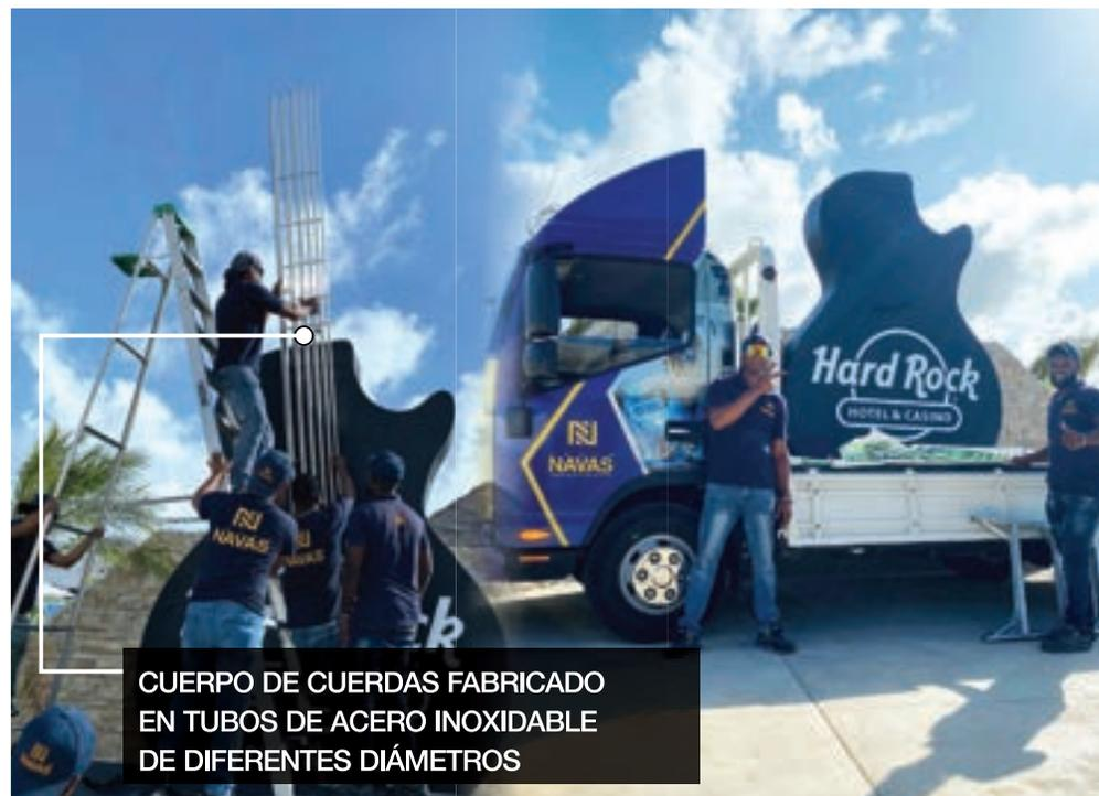
CUERPO DE CUERDAS FABRICADO EN TUBOS DE ACERO INOXIDABLE DE DIFERENTES DIÁMETROS
