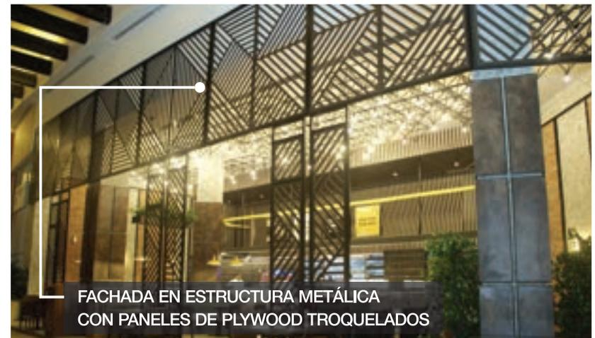
FACHADA EN ESTRUCTURA METÁLICA CON PANELES DE PLYWOOD TROQUELADOS
