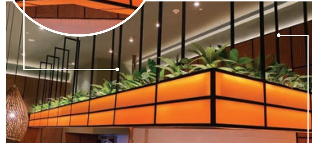
ESTRUCTURA METÁLICA COLGANTE CON REVESTIMIENTO DE PANELES ACRÍLICOS Y APLICACIÓN DE ACRÍLICOS DIFUSORES
