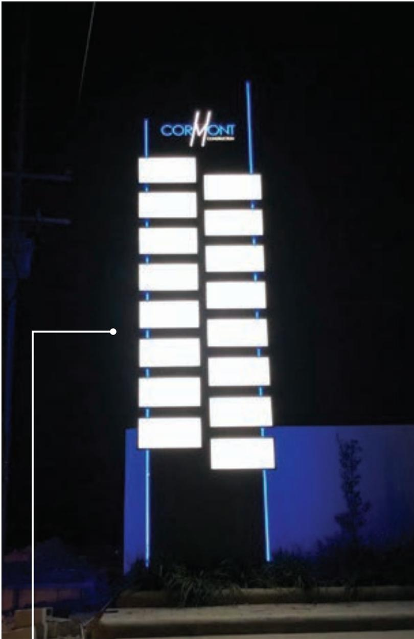
MONOLITO DE 12m DE ALTURA EN ESTRUCTURA METÁLICA CON RECUBRIMIENTO DE ACM Y CAJAS DE LUCES
