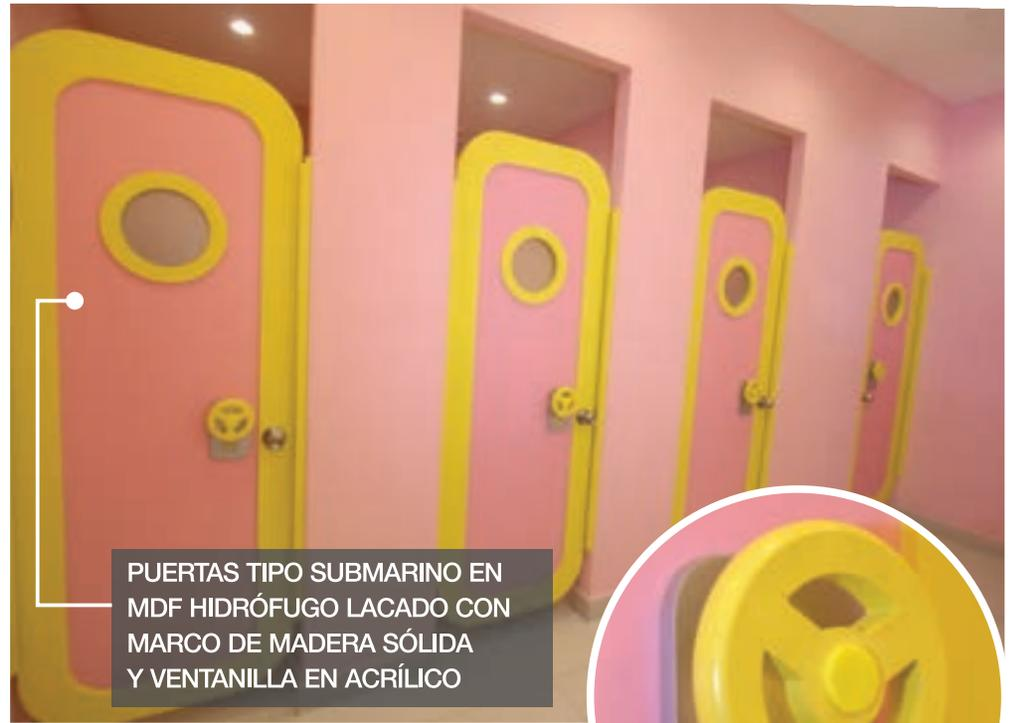
PUERTAS TIPO SUBMARINO EN MDF HIDRÓFUGO LACADO CON MARCO DE MADERA SÓLIDA Y VENTANILLA EN ACRÍLICO
